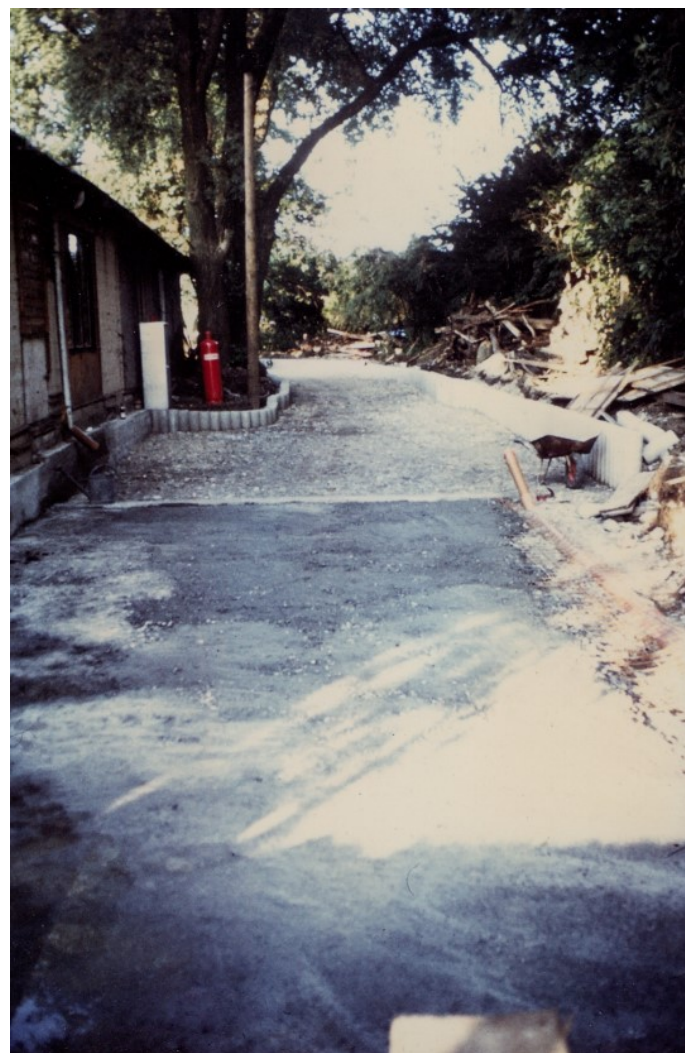
DLRG-Heim: Die Zufahrt zur neuen Bootsgarage ist im Werden. Die Arbeiten wurden in Eigenleistung erbracht. Bild DLRG-Archiv
