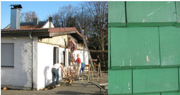
Beginn der Arbeiten an der Giebelseite: Passive und aktive Mitglieder packten mit an. Rechtes Bild: Unter der Holzverkleidung oben am Giebel kamen noch Reste der ursprünglichen grünen Holzschindelverkleidung hervor.
