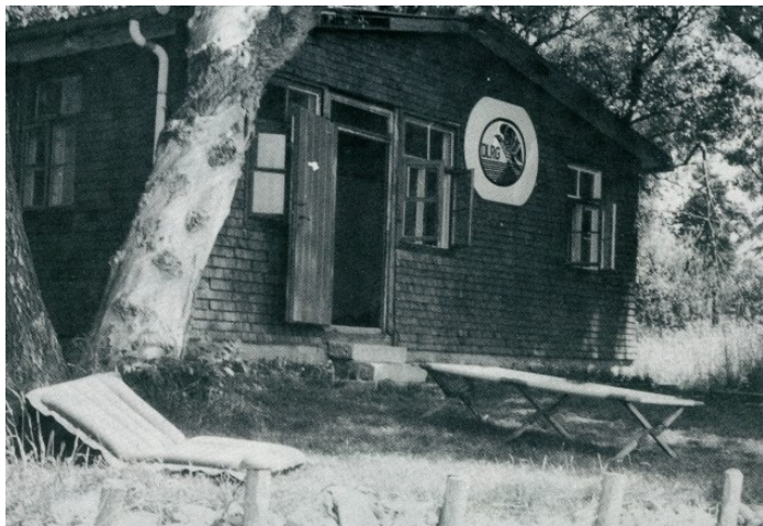
DLRG-Heim 1960: Ansicht Seeseite: Holzfassade mit grünen Schindeln. Der „Spähende DLRG-Adler“ an der Fassade der Rettungsstation wurde von dem damaligen Rettungsschwimmer Kurt Eble aus Eriskirch gemalt. Bild: DLRG-Archiv
