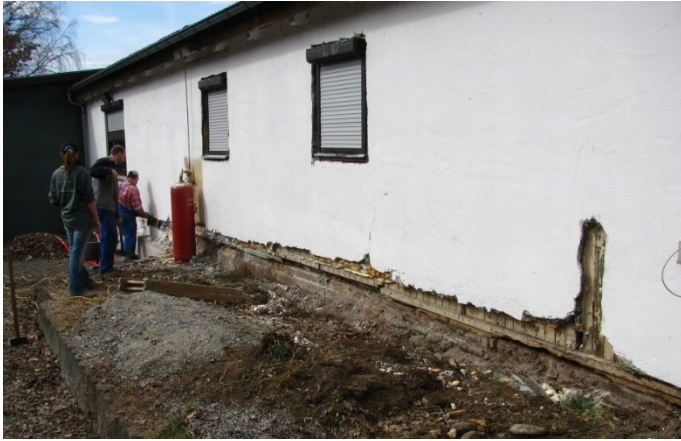
DLRG-Heim Rückseite (2010): Morsche Balken entlang des Fundaments wurden von einer Fachfirma ausgewechselt
