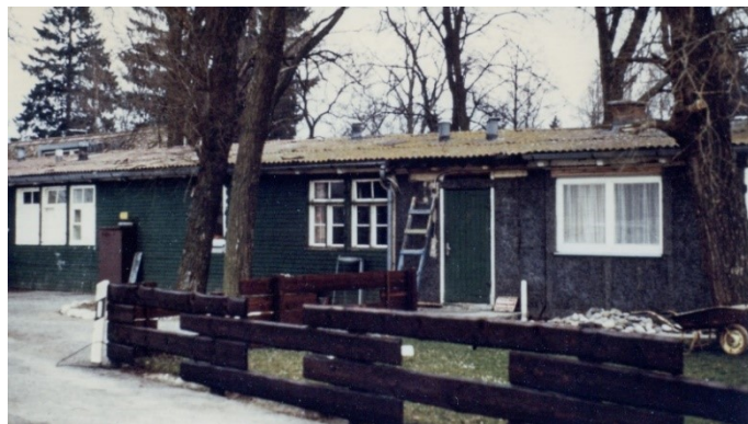
DLRG-Heim ca. 1968: Noch ist viel zu tun: Fassade, Fenster, Türen...
