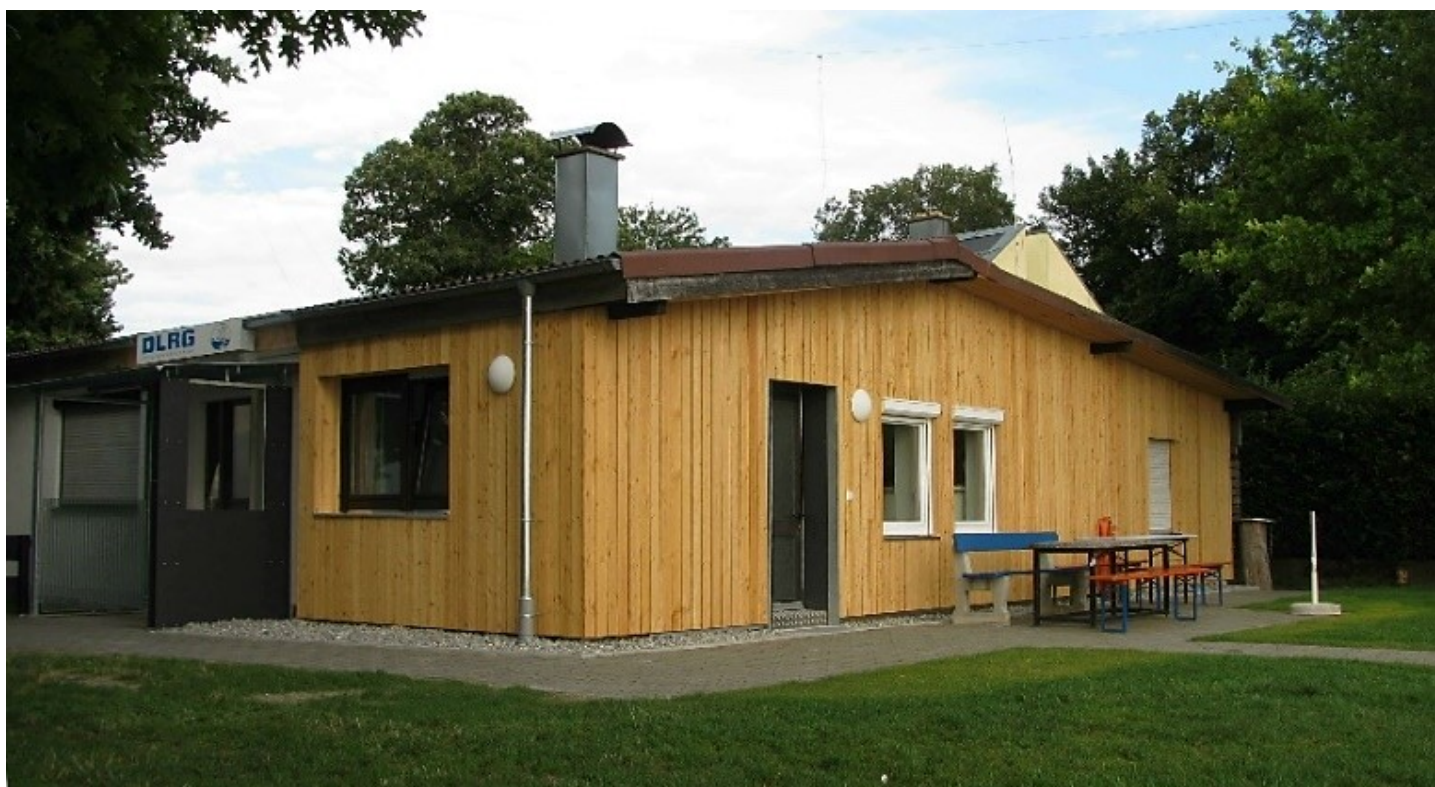
Das DLRG-Heim nach der Sanierung 2010: Die neue, naturbelassene Holzfassade an der Seeseite passt gut zum Umfeld des Bodenseeuferers
