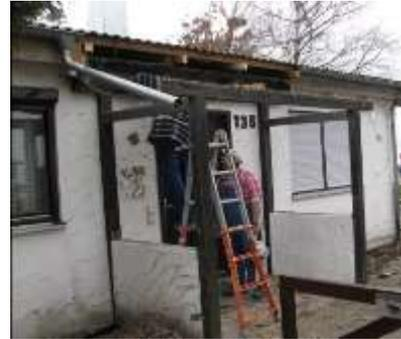
Abriss des Windfanges am Haupteingang: Er ist baufällig und muss einer neuen Konstruktion weichen.
