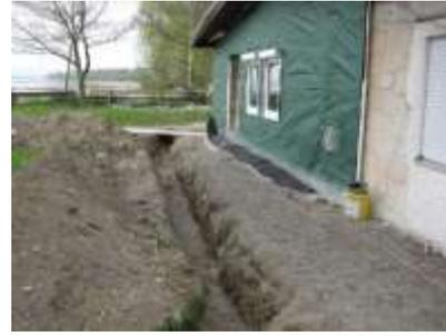
**Zweiter Drainagegraben:** Nach Unterfüllung mit Rollkies wird noch ein Drainagerohr eingelegt, welches an den Regenwasserablauf angeschlossen wird.
