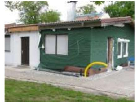
Nachdem die Drainagerohre entlang der Giebelwand eingebracht sind und die übrigen Außenwände neu verputzt und gestrichen worden sind, konnte der neue Windfang für den Haupteingang montiert werden.
